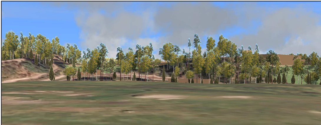
Over: Utsikt fra Tyrimyra deponi (hundeklubben), mot det nye industriområdet. Høydebassenget ligger på kollen til venstre. Terrenget vil trolig ligge noe høyere enn dagens nivå ved skiskytterarenaen, og ny bebyggelse vil bli synlig fra Tyrimyra og fra Hov næringsområde.
